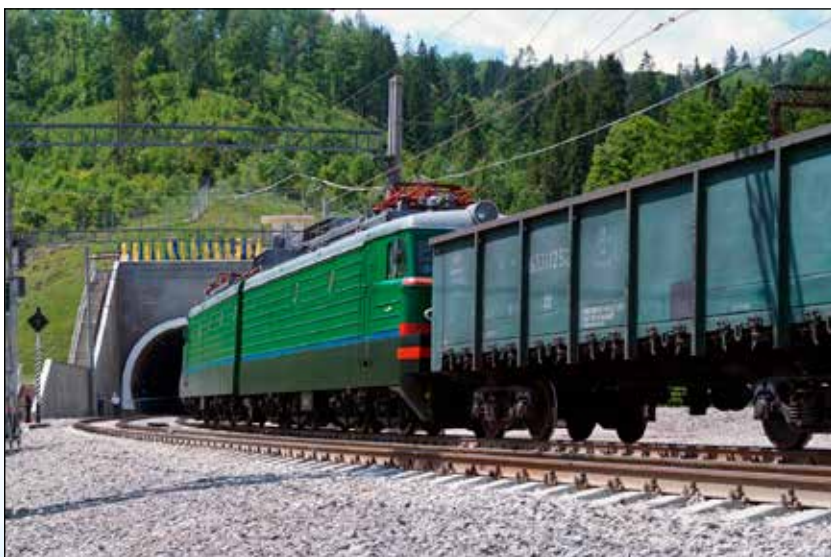
首列货物列车通过贝斯基德新建铁路隧道（2018年5月24日，乌克兰）
